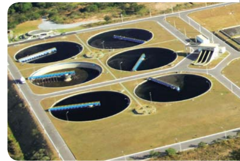
ETE Arrudas - Decantadores secundários
