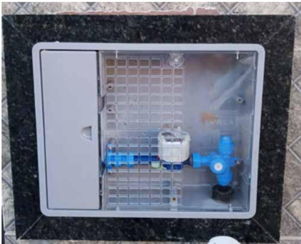
Nesse caso, basta acessar um dos Canais de Relacionamento, informar que sua ligação é simples (um único imóvel e um só hidrômetro) e que você deseja a ligação com montagem pela Copasa/Coponor de caixa em policarbonato e o kit em PVC, junto com a execução da ligação.
