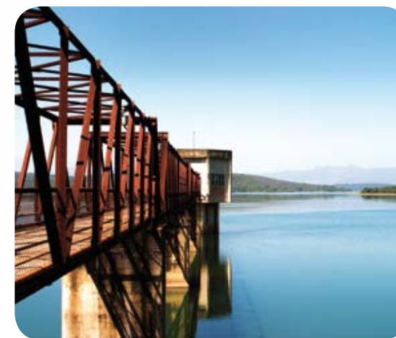
Sistema de abastecimento Serra Azul - Juatuba
