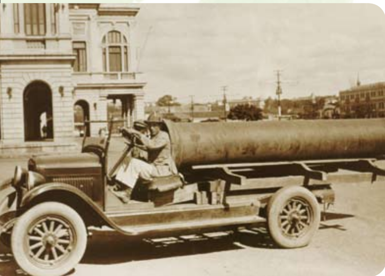
Início do saneamento em Minas Gerais - Belo Horizonte
